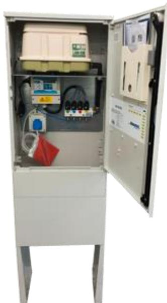
Если настенный монтаж невозможен или нежелателен, Вы можете установить наружные будки в любое удобное место. Мы предварительно устанавливаем блок управления KlägoFix в армированные стекловолокном наружные будки и доставляем их готовыми к подключению.
